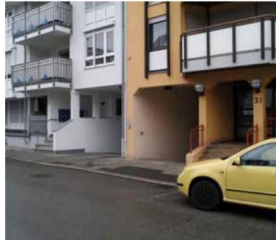
Sindelfingen Bahnhofstraße: Gebäudefronten dominiert durch Tiefgarageneinfahrten
